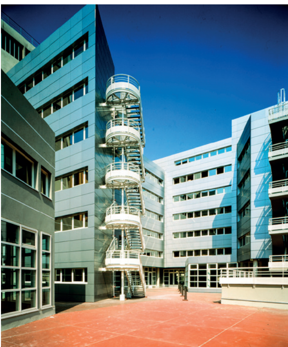
36 RUE DU CHEMIN VERT
