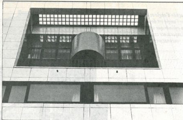
La façade sur l'avenue de Saxe : précision du dessin, réglé sur les dimensions (60 x 60) du carreau de revêtement
